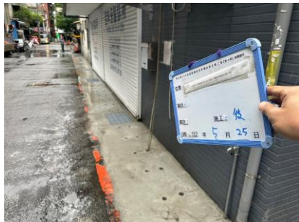
三民路75巷新增溝蓋-施工後
