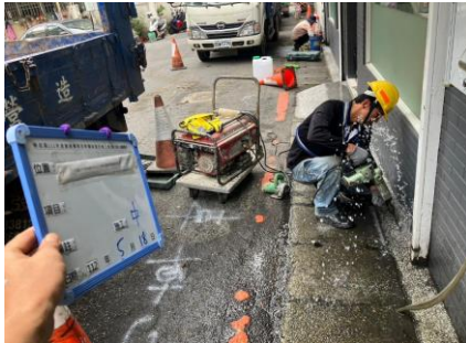
三民路75巷新增溝蓋-施工前
